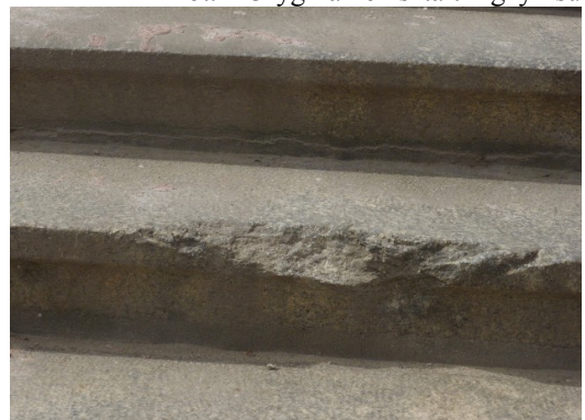
Fot.12 Ubytek w granicie kwalifikujący się do flekowania
