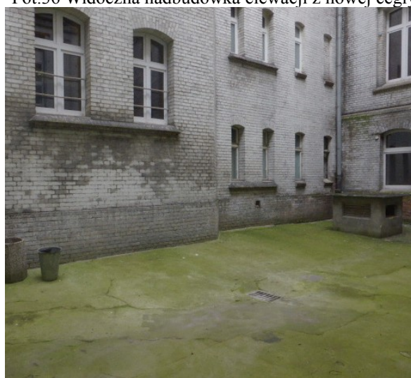
Fot.37 Zawilgocenia w murze
