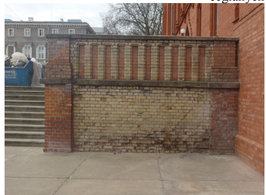
Fot.8 Ubytki muru od strony elewacji północnej
