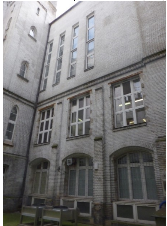
Fot.35 Silnie skorodowane wzmocnienia okien
