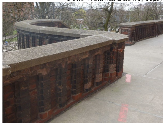
Fot.7 Widoczne cementowe wstawki kształtek ceglanych
