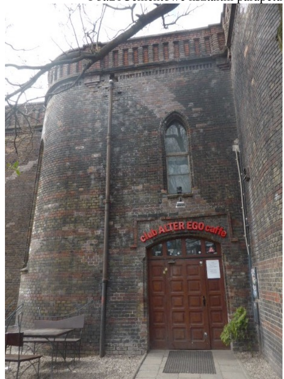
Fot.22 Wysoka ściana od strony ul. Dworcowej, wstawki ze współczesnej cegły
