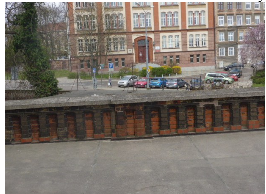
Fot.6 Wstawki z nowej cegły
