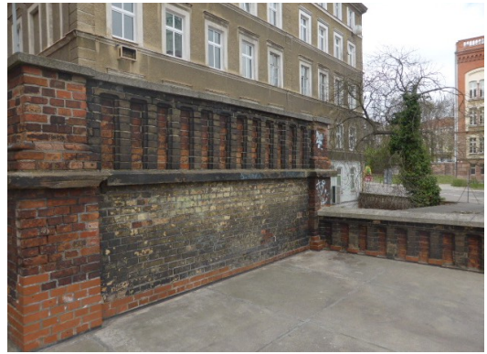
Fot.5 Silnie zanieczyszczone cegły i kształtki balustrady
