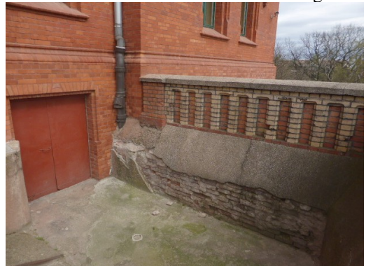
Fot.10 Wtórna zaprawa na ceglach do usunięcia
