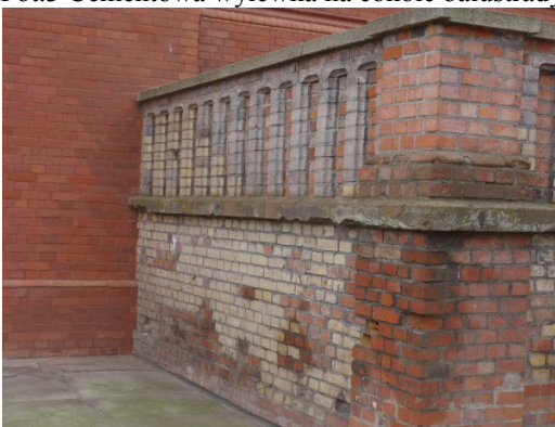
Fot.4 Fragment mokrego muru, współczesne wstawki ceglane
