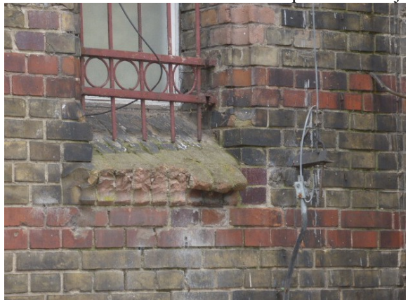
Fot.21 Cementowe kształtki parapetu
