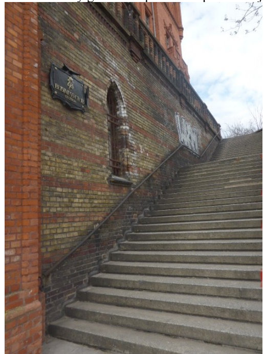
Fot.16 Silne wysolenia wokół okna ściany
