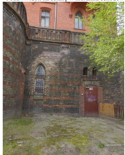
Fot.25 Wtórne obramienie drzwi, duża ilość wstawek ze współczesnej cegły
