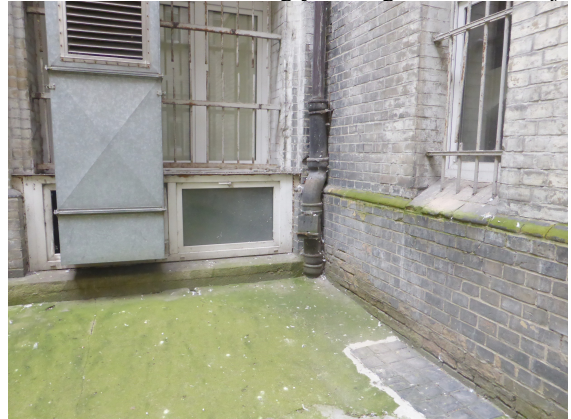
Fot.34 Betonowa posadzka tarasu do wymiany
