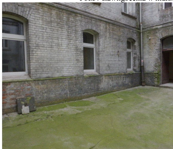
Fot.38 Silnie zniszczona partia cokołowa i obramienie drzwi
