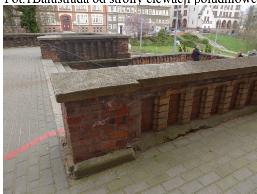
Fot.2 Balustrada przy schodach, nakrywy z lastriko
