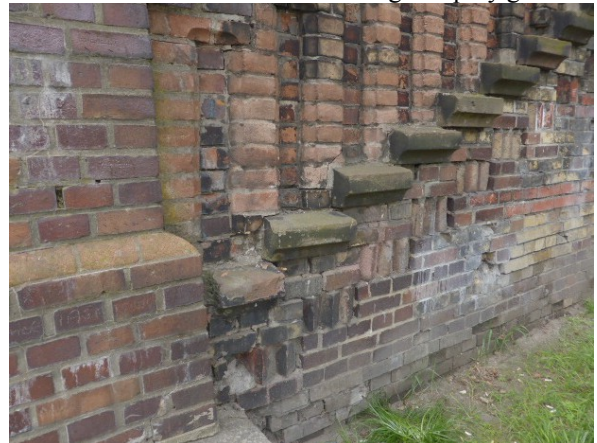
Fot.19 Duża ilość cementowych kształtek i wtórnych cegieł
