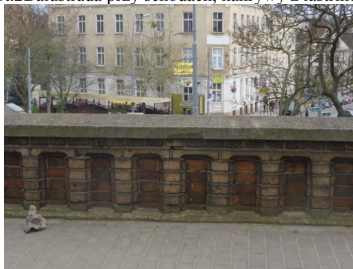
Fot.3 Cementowa wylewka na cokole balustrady
